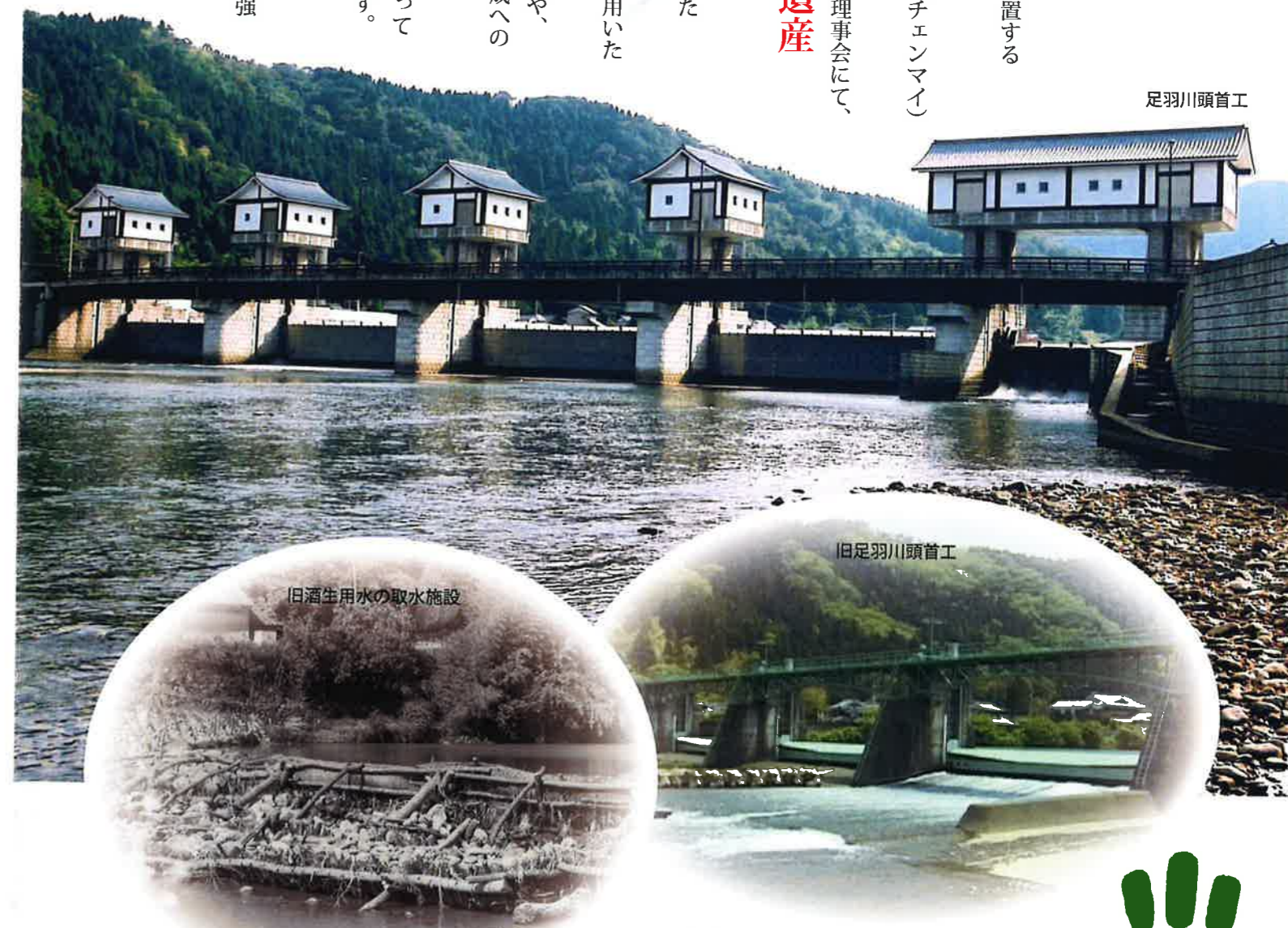
足羽川堰堤土地改良区連合
